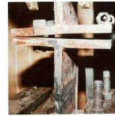
Figure 11 : Ruine de l'assemblage par rupture des boulons.
