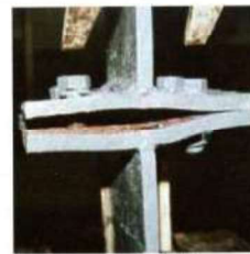
Figure 10 : Rupture du filetage de l'écrou du boulon a empêché la déformation de la platine de continuer.
